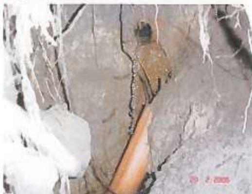
Photo 2 : Suffosion créée par rupture d'un tuyau de drainage.
